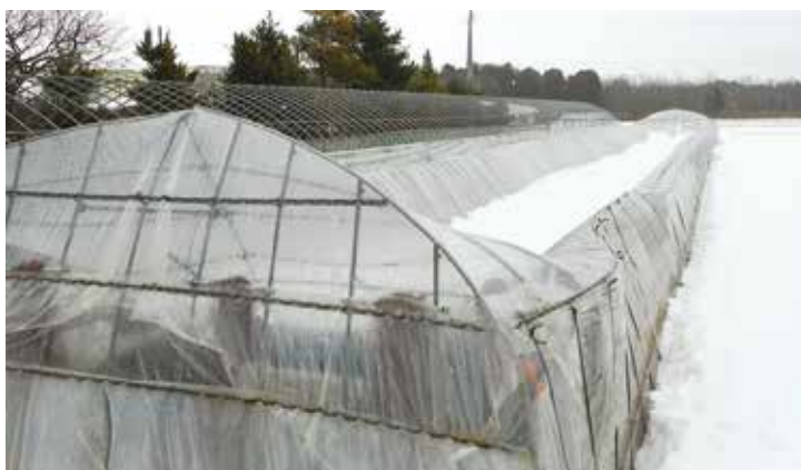
天井が雪で圧迫され潰れたハウス 上：令和5年12月・男鹿市 下：令和5年12月・潟上市
